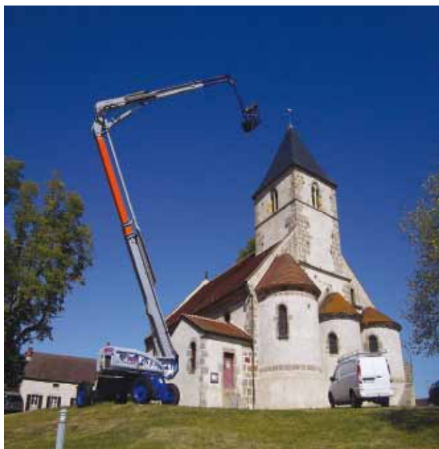
L'intervention avec la nacelle
